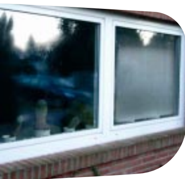
Links met Pilkington Activ™ coating, rechts zonder.
